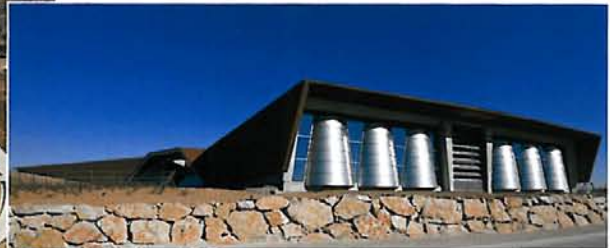
Chal Bodegas Portia , Ribera del Duero, Espagne, 2010, arch. Foster and Partners. Le design trilobé adopté exprime les trois étapes de la production, fermentation en cuves d'acier, vinification en barriques de bois, puis vieillissement en bouteilles. Structure béton, habillage en Corten. Propriétaire Groupe Faustino.
