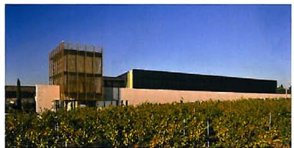
Cava Santaldué , Gironès, arch. M2D'Architectes, 2011. Béton brut de décoffrage, pare-soleil bois. Lignes minimalistes pour cette cave viticole rassemblant stockage de bouteilles, espaces vente et dégustation.
